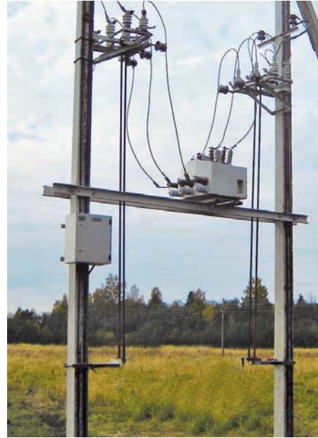
КС-120Р устанавливается на две опоры
