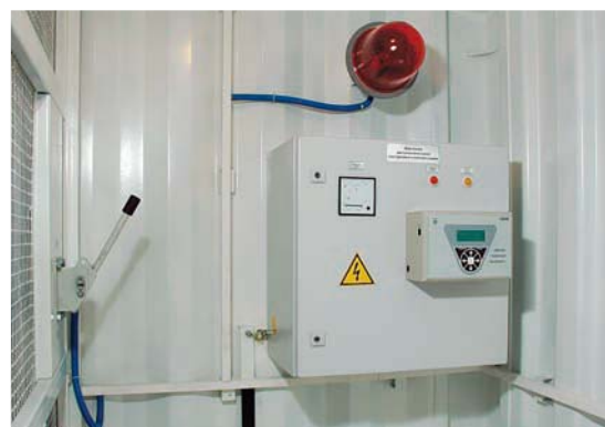
Рис. 2 Система автоматической настройки САМУР
